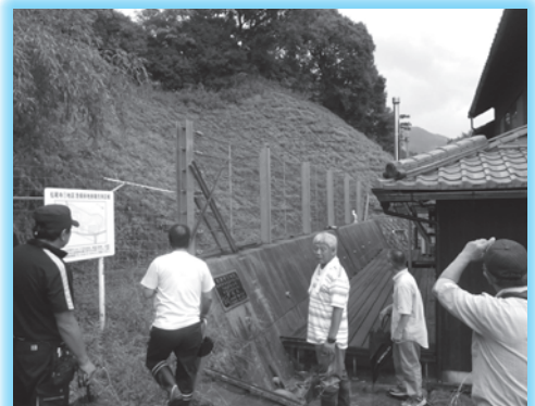
松尾寺南自治会での取り組み 字内の危険な箇所を点検されました。
